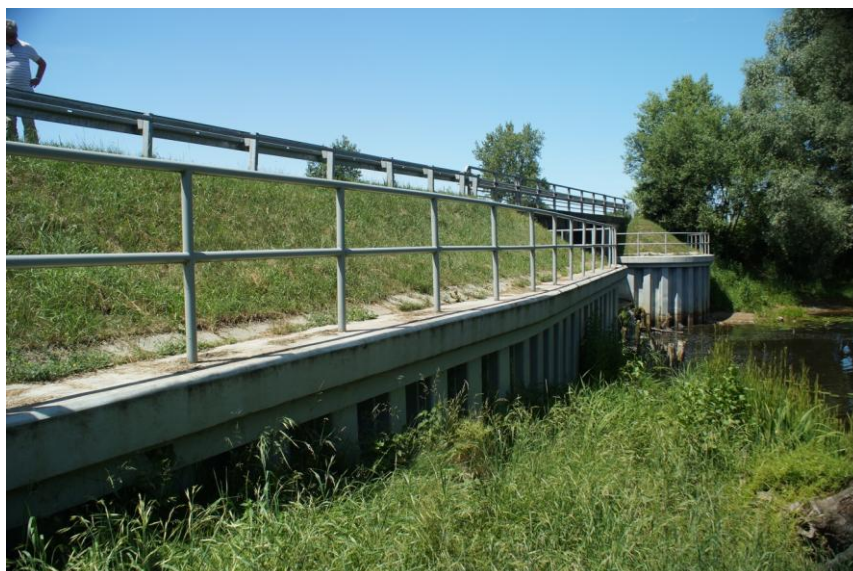
Ryc. 4. Widok na stalowe umocnienia skarpy nasypu od strony wody dolnej (fot. własna).
