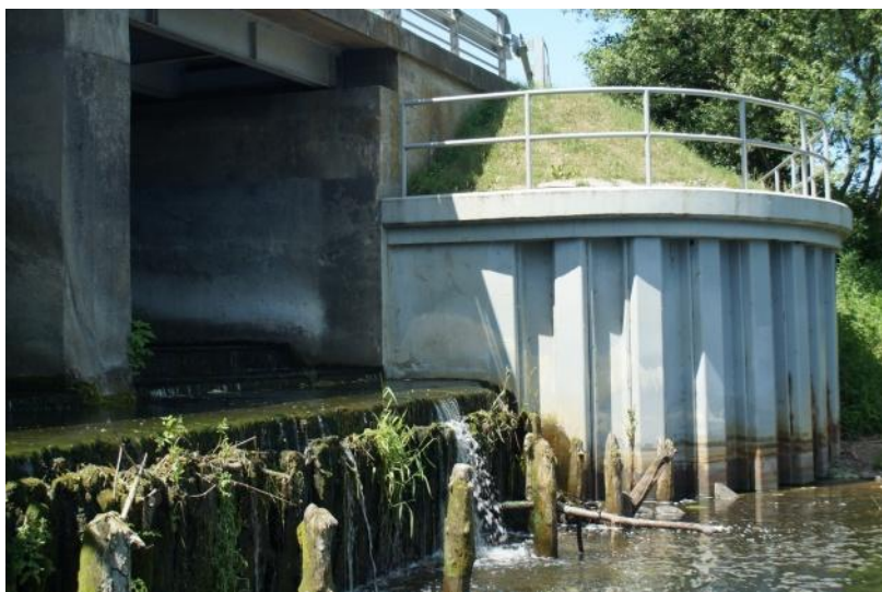
Rys. 3 Widok piętrzenia od strony wody dolnej. Widoczne umocnienia stalowe skarpy (fot. własna).
