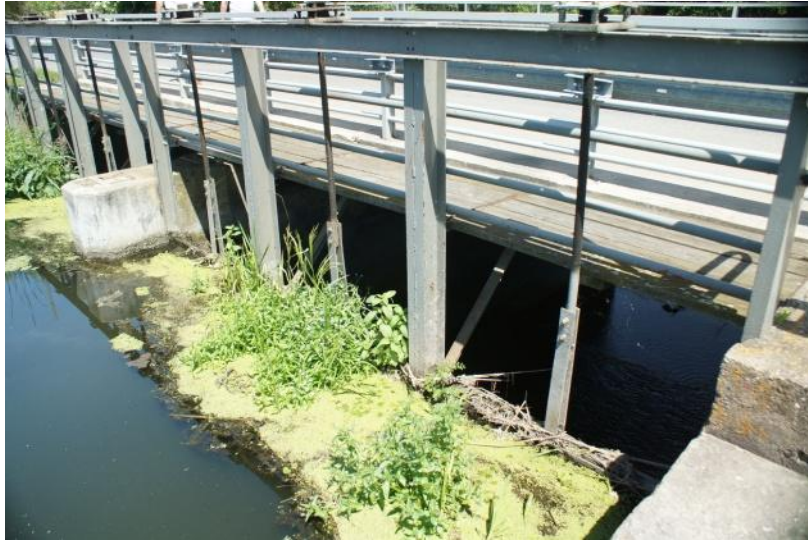
Ryc. 2 Widok piętrzenia od strony wody górnej (fot. własna)
